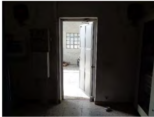
Salida por acceso sala comunicaciones
